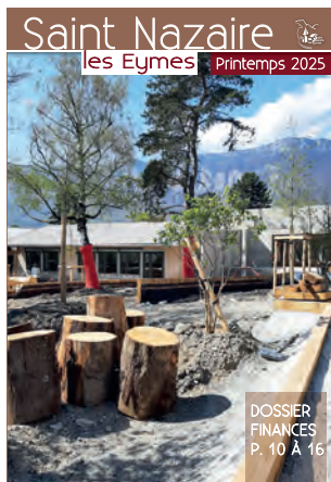
Photo de couverture : travaux de rénovation de l'école élémentaire
